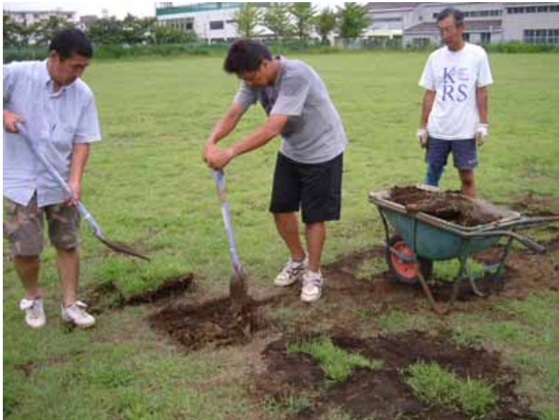
スポーツ利用者による補修作業
